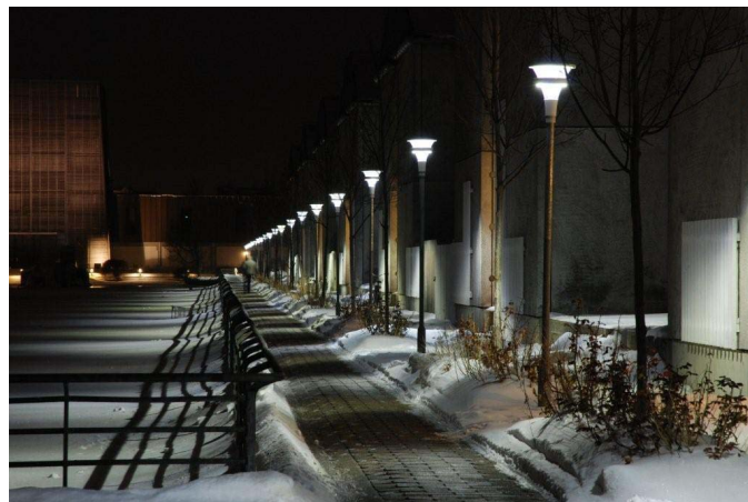
Bild 7: Straßenbeleuchtung von Albertslund (© Stadt Albertslund)
